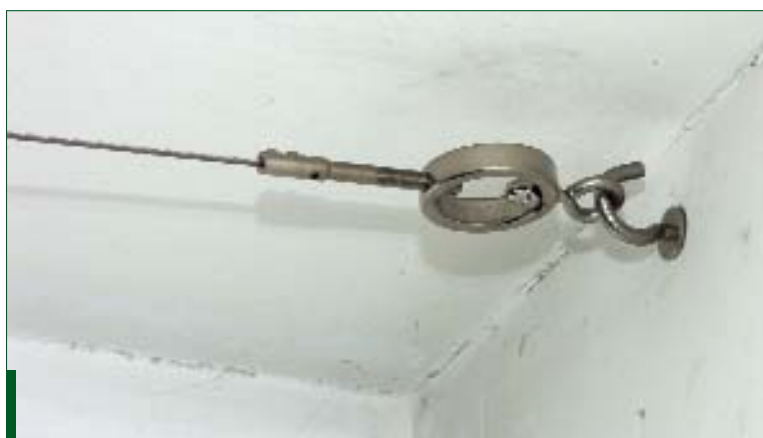
Mocowanie karnisza linowego do bocznej względem tła ściany.
